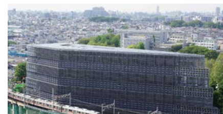
環境エネルギー棟
